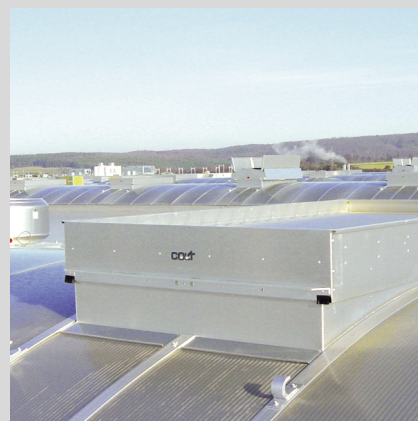
▲ kłapa EuroCO wbudowana w pasmo świetlne
