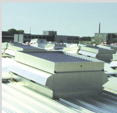
▲ EuroCO na podstawie wentylacyjnej Weatherlite - wentylacja naturalna niezależna od opadów
