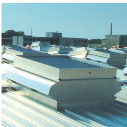
System wentylacji odporny na opady deszczu – Typ Weatherlite (na zdjęciu połączony z EuroCO)
