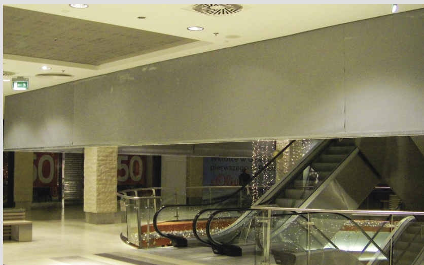
Firma Colt zamontowała w sumie ok. 220 mb kurtyn dymowej w centrum handlowym w Płocku.
