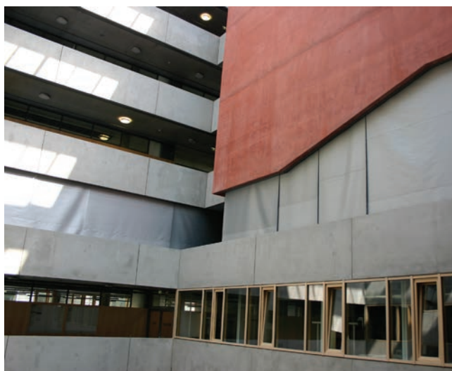
Szkoła Wyższa Zawodowa we Frankfurcie - Kurtyny dymowe zapobiegają przedostawaniu się dymu z jednej strefy do drugiej
