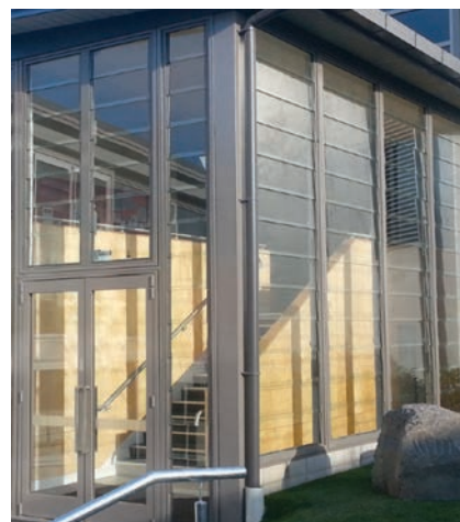
Budynek Harkinsa, Carmel College, Auckland, Nowa Zelandia
