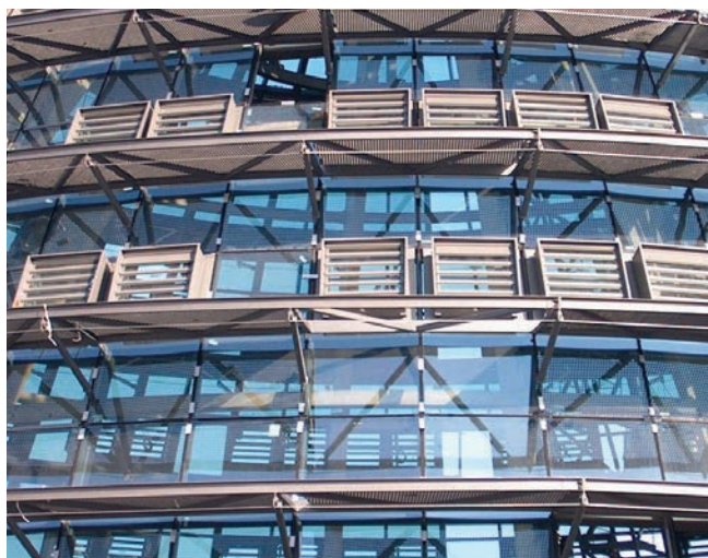
Forum Almada, Portugalia - Rozbudowany system kontroli rozprzestrzeniania się dymu i ciepła, system ochrony przed nasłonecznieniem i naswietla dachowe
