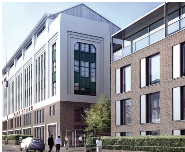
Highbury Square, Londyn – System Colt Shaft wykorzystany do wentylacji korytarzy
