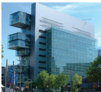
Budynek Sądu Cywilnego w Manchesterze – Okna Coltlite wykorzystane do wentylacji naturalnej
