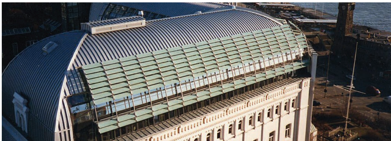
Hotel Hafen, Hamburg - system żaluzji ze szkła spiekanego wpuszczających przez dach światło do wnętrza budynku jednocześnie ograniczający nagrzewanie spowodowane przez światło słoneczne
