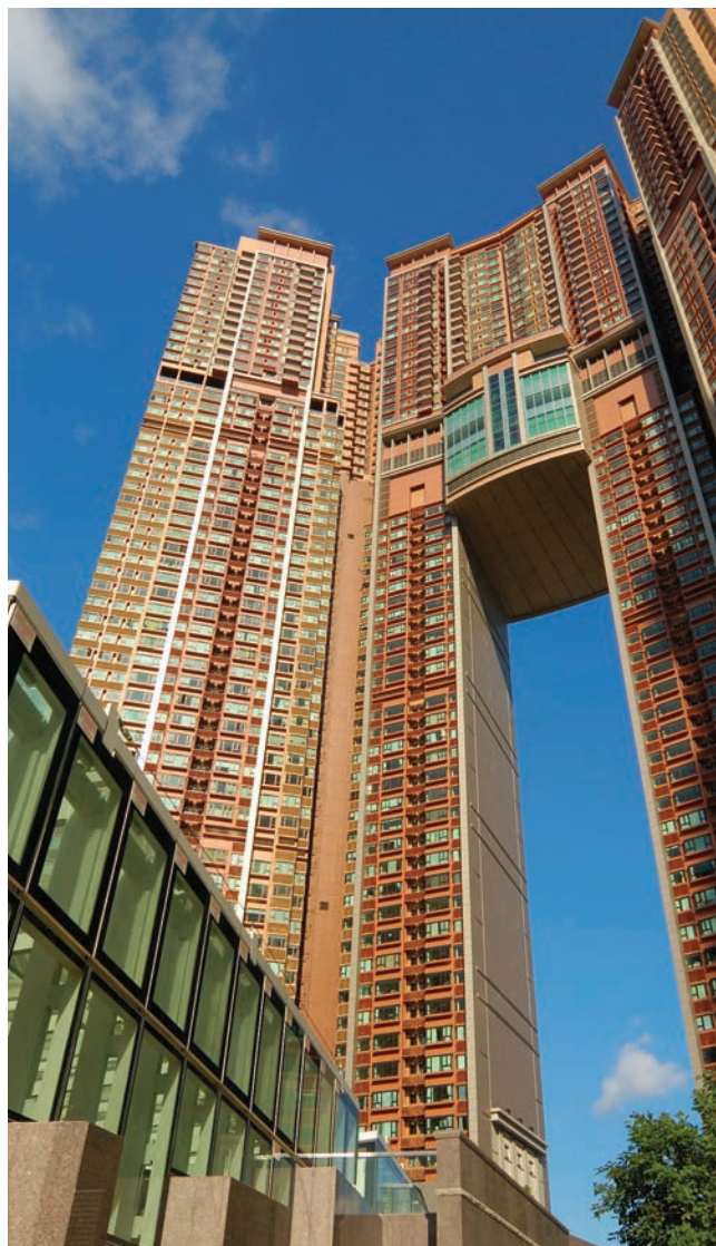
Union Square, Hong Kong – System kontroli rozprzestrzeniania się dymu i ciepła
