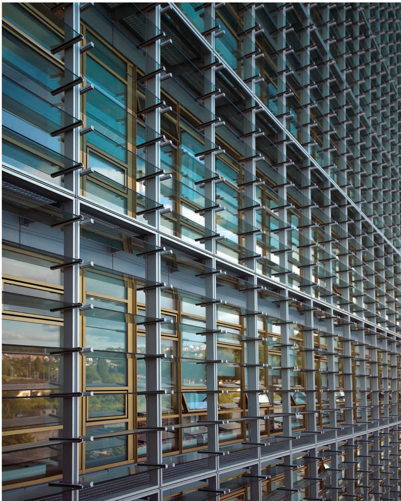
Budynek urzędu hrabstwa Cork, Irlandia - Aktywna fasada wentylowana Colt zmniejsza zapotrzebowanie na klimatyzację
