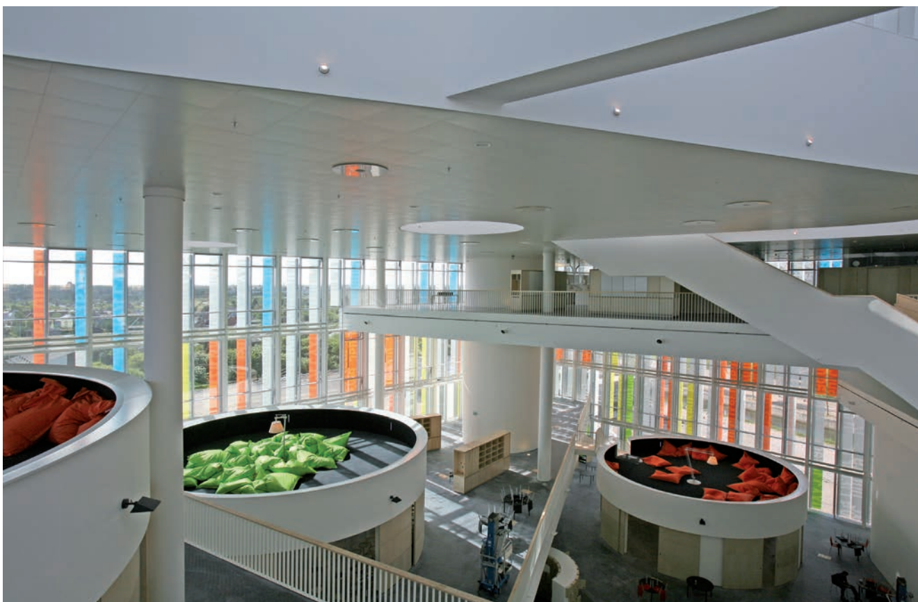
Budynek Ørestandens Gymnasium, Dania – Firma Colt zaprojektowała i zainstalowała 700 laminowanych i dopasowanych żaluzji szklanych Shadoglass umożliwiających wentylację i zacielenie na fasadzie o powierzchni powyżej 1700 m 2 . Zastosowanie różnokolorowego szkła zapewniło młodzieżowy i zabawny wygląd.
