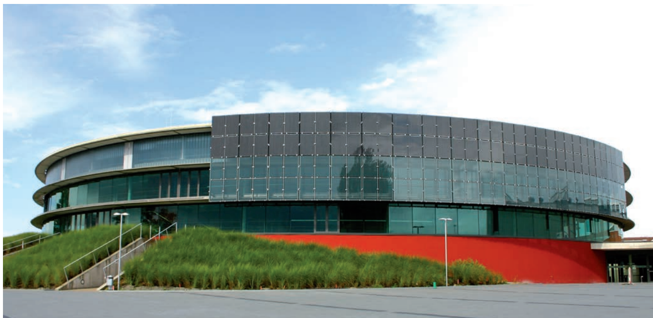
Stadion EWE Arena, Niemcy – Firma Colt zaprojektowała i wykonała ruchomą ścianę pełniącą funkcję osłony przeciwsłonecznej, wyposażoną w ogniwa fotowoltaiczne, zapewniającą ochronę przed nasłonecznieniem i wytwarzanie energii elektrycznej
