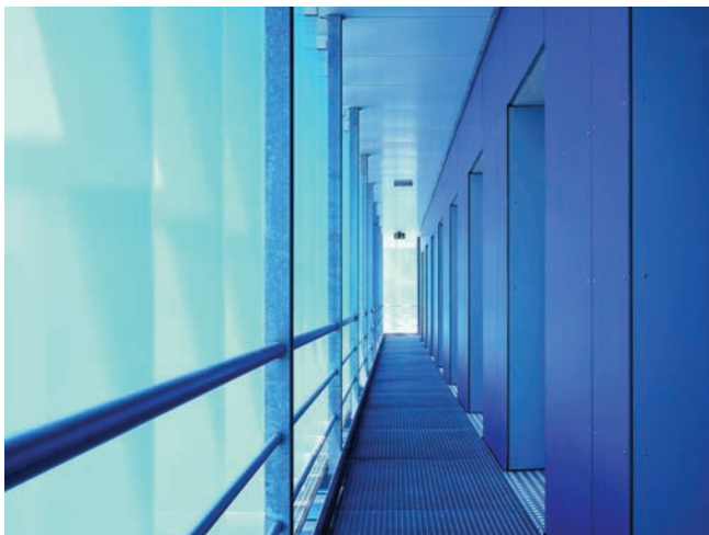
Budynek Eawag Forum, Chriesbach, Szwajcaria – System pionowych żaluzji szklanych Colt działa jak dodatkowa fasada
