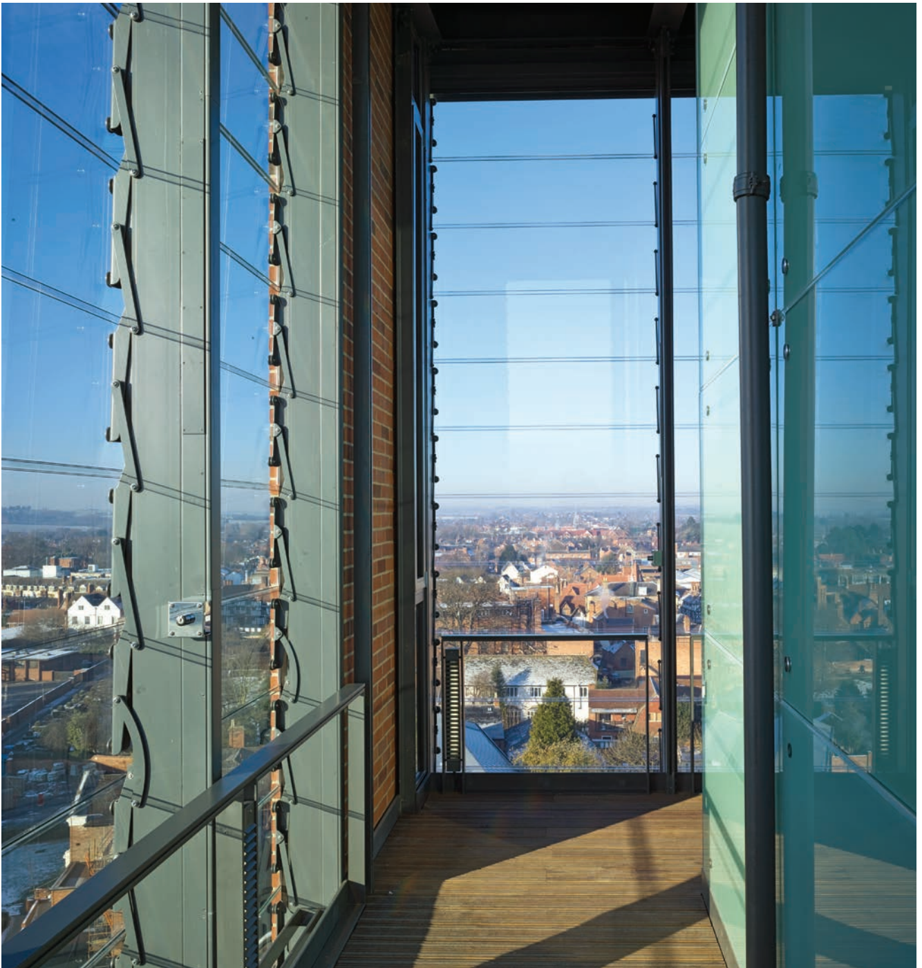
Royal Shakespeare Company, Stratford - 4-stronne, ruchome okno żaluzjowe z funkcją wentylacji – typ LS-4
